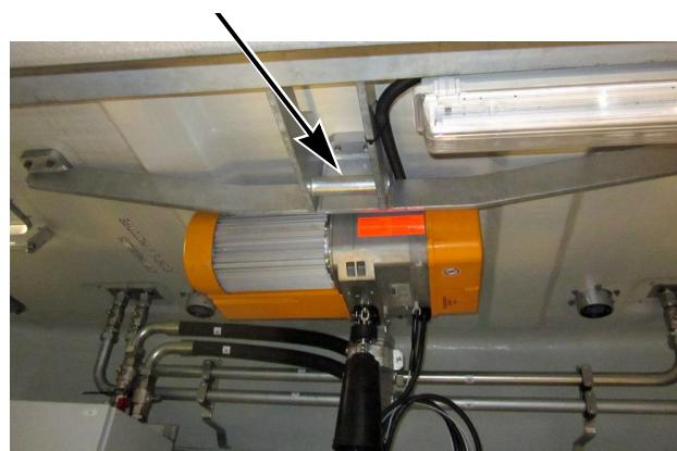
Abb. 18 Personenanschlagpunkt an der Tragstruktur
