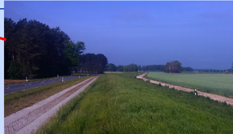
Bömenziener Deich 2.BA 1,7 km Fertigstellung 2019
