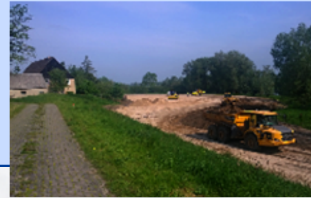
linker Alanddeich, OL Wanzer 1,5 km, Fertigstellung Okt. 2020
