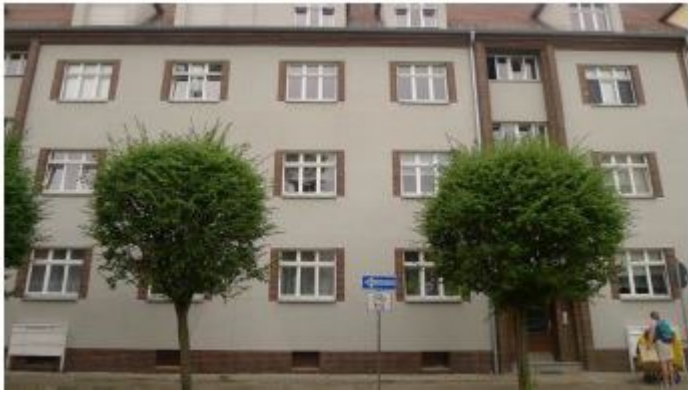
Gebäude II Straßenfront
