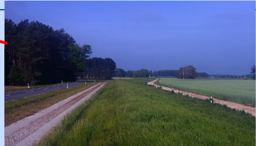
Bömenziener Deich 2.BA 1,7 km Fertigstellung 2019
