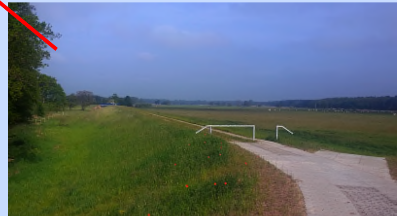
Bömenziener Deich 1.BA 1,5 km Fertigstellung 2015
