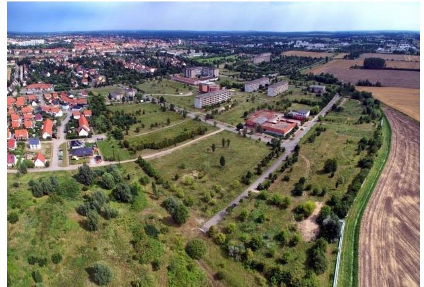
Nach fast vollständigem Abriss
