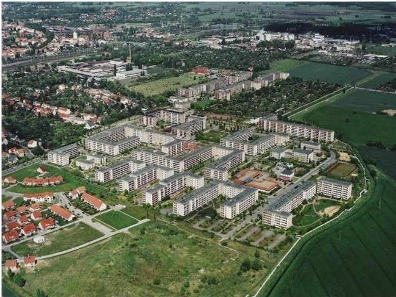
Vor Beginn der Abrissarbeiten
