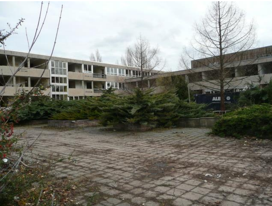
Kurz vor Abriss 2010
