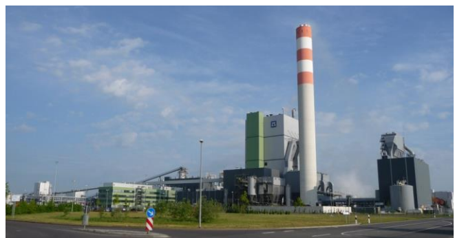
Abb. 6: Zellstoffwerk Arneburg, Foto: E. Kraul
